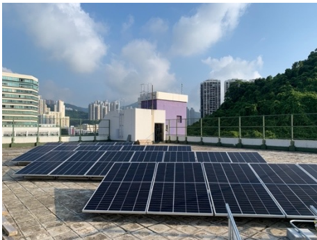
天台安裝太陽能板
