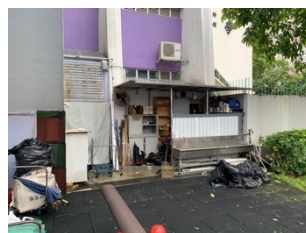
學生洗手盆翻新工程
